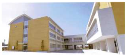
正面玄関付近
